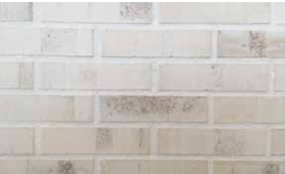
Metselwerk ter hoogte van de begane grond: een crème beige geglaazuurde baksteen.
